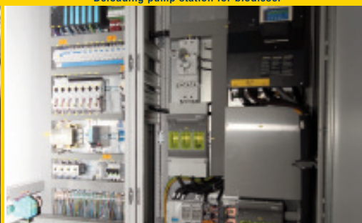
Schaltschrankbau Manufacturing of Control cabinet
